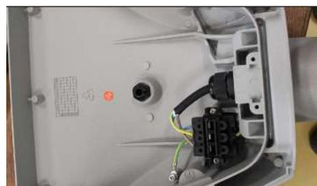
13. Die Kabelverschraubung festziehen.
