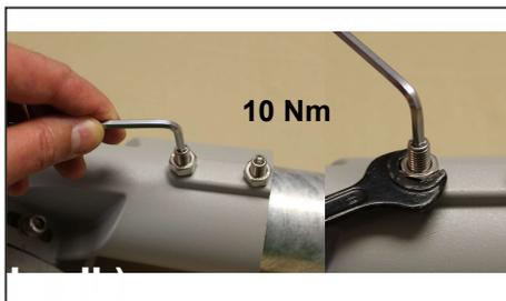
18. Die Neigung der Leuchte mithilfe der Schrauben am Gelenk auf die gewünschte Position einstellen. Empfohlener Drehmoment 10Nm.
