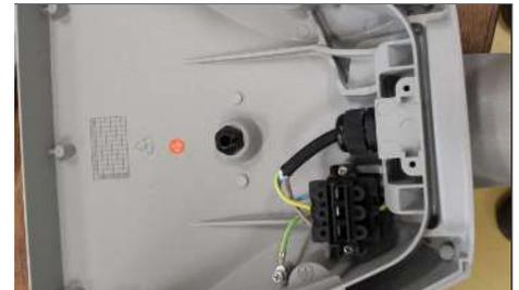
13. Die Kabelverschraubung festziehen.
