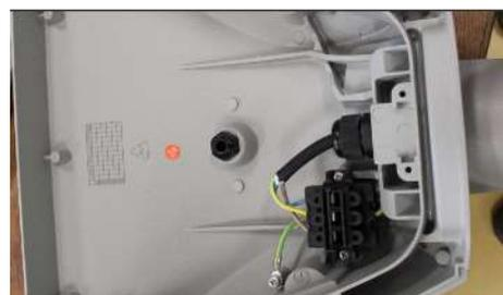
13. Die Kabelverschraubung festziehen.
